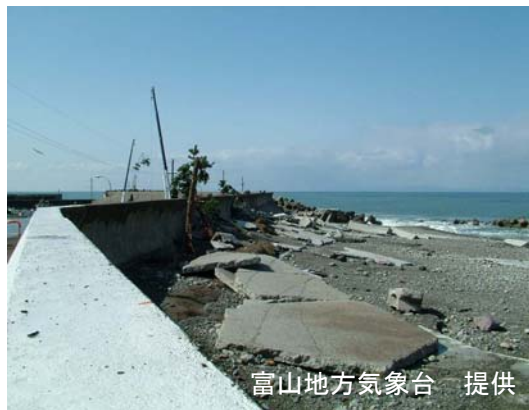
入善港東防波堤 護岸施設の損傷および電線に引っかった木の枝
