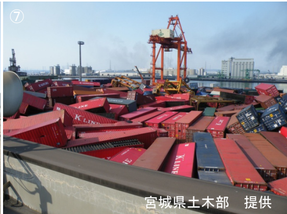
仙台塩釜港高砂コンテナターミナルの様子【3月12日9:39撮影】
