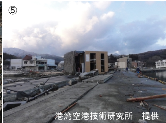
女川漁港の海側に基礎ごと横転した鉄骨造構造物【3月16日撮影】
